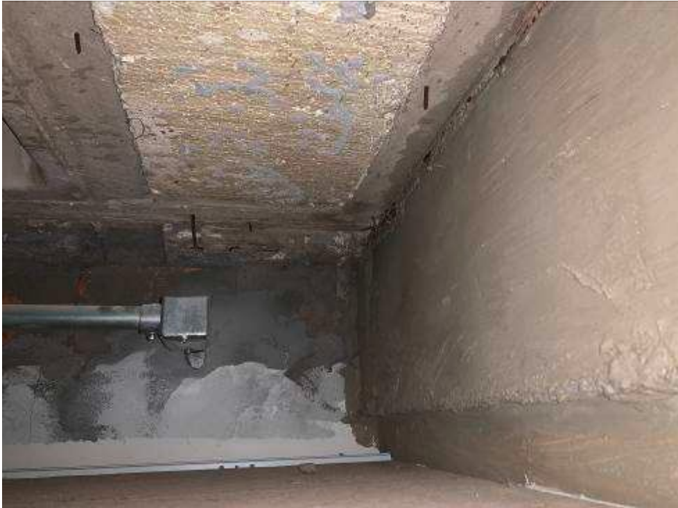
Calha Cobertura (seca)
