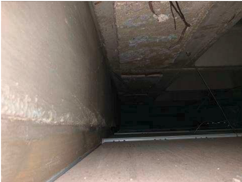
Calha Cobertura (seca)
