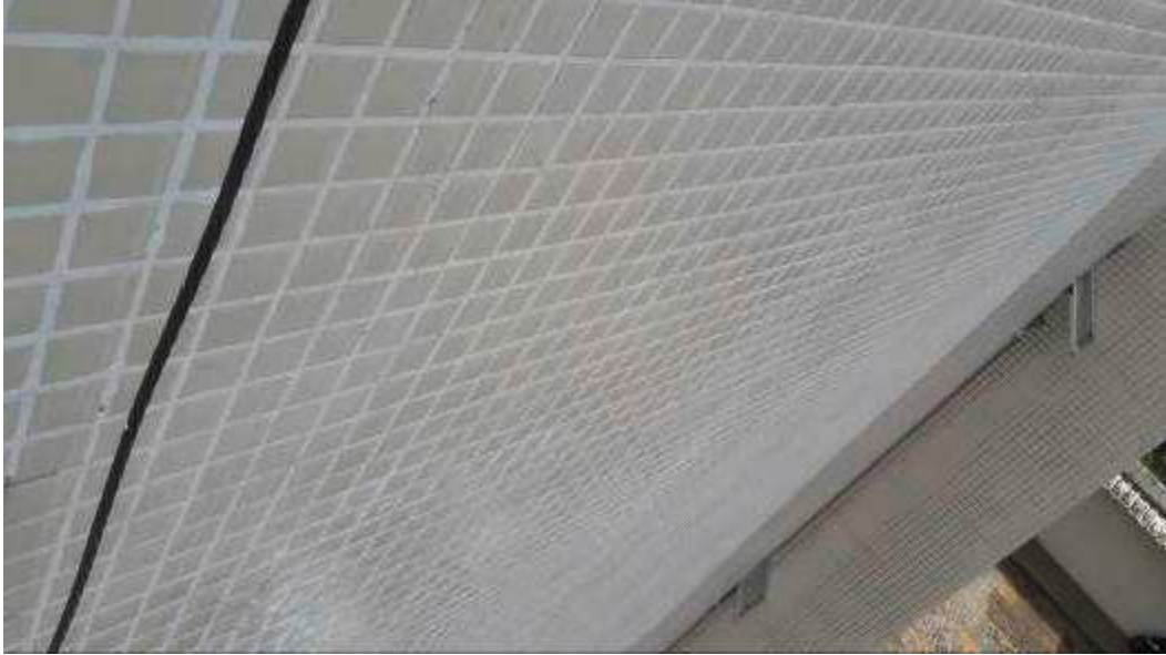
Trinca Fachada
