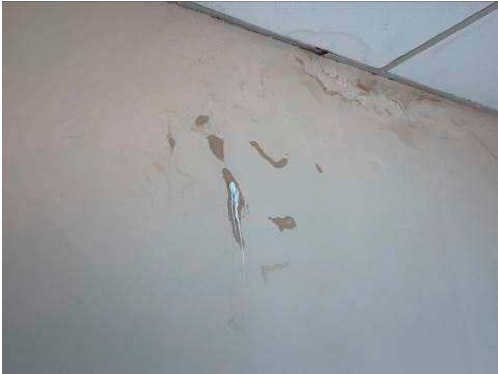
Eflorescência Parede
