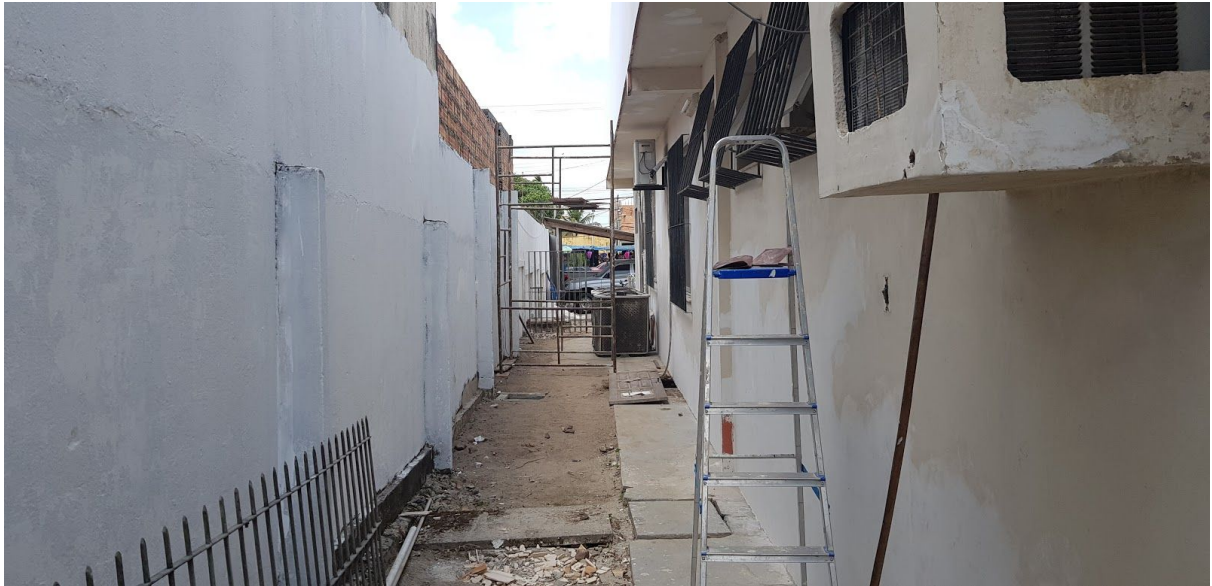
Acesso lateral da VT/Capanema
