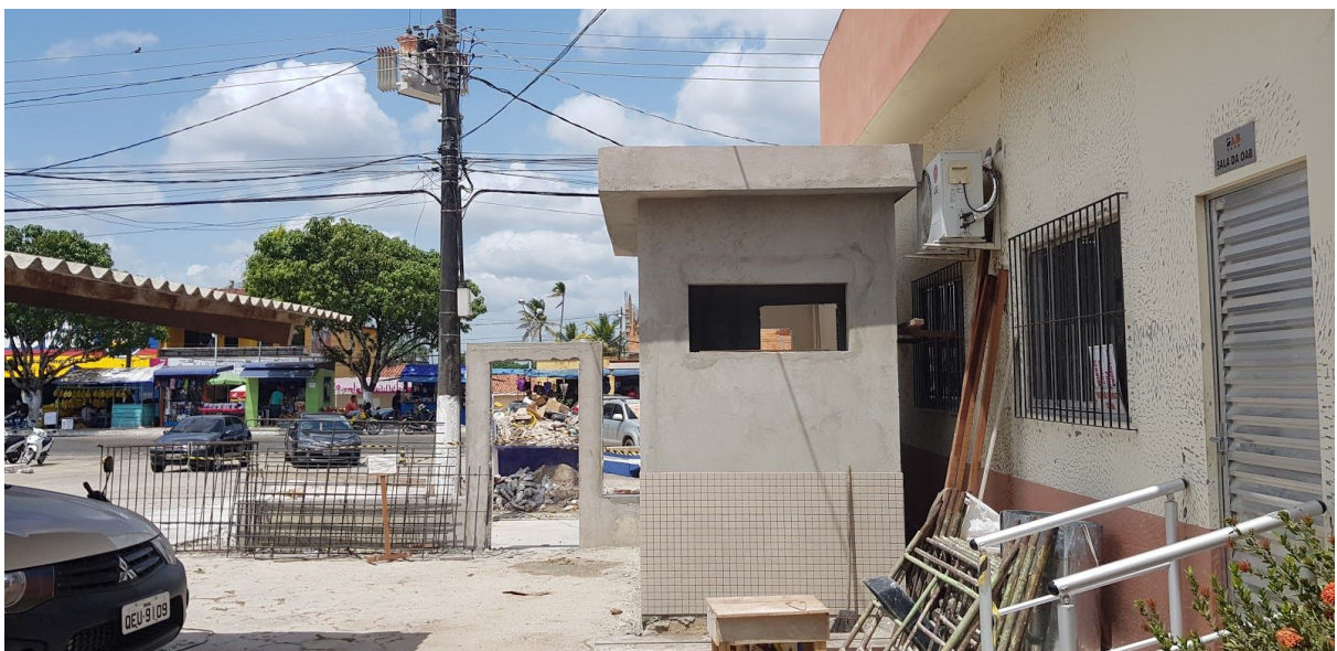
Vista interna da VT - Guarita e muro
