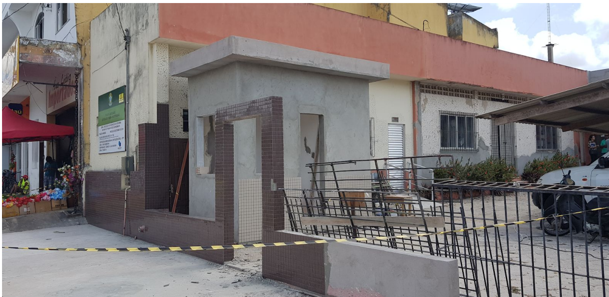
Vista externa da VT - Muro e Guarita
