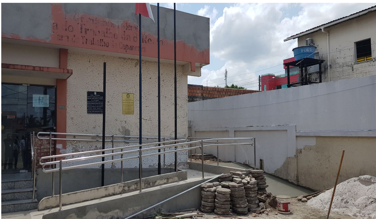
Rampa para deficientes para VT e para o Banheiro externo PCD
