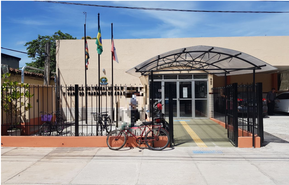
Fachada da Vara do Trabalho de Abaetetuba
