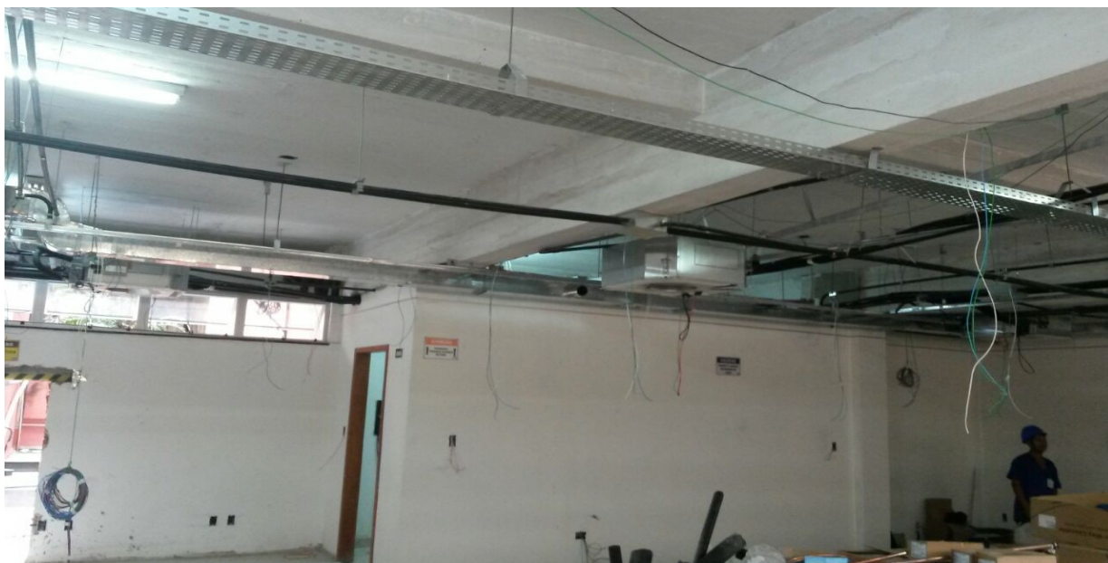
Área de trabalho/instalações
