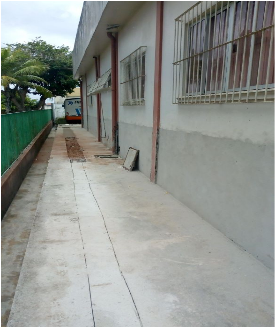
Vista lateral com drenagem
