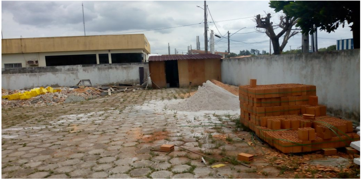
Canteiro de obras
