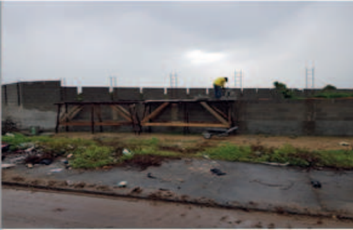
Lateral do muro - frente rodovia
