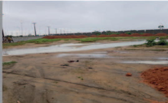
Área interna - vista material de aterro
