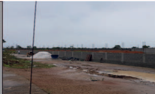
Área externa - vista frontal do muro
