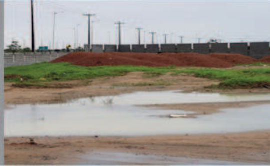
Área interna alagada pelas chuvas
