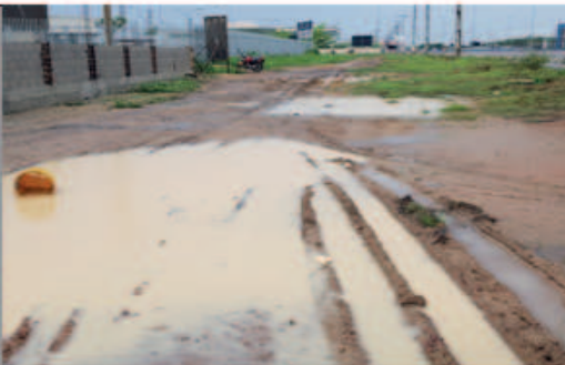
Área externa - frente do terreno
