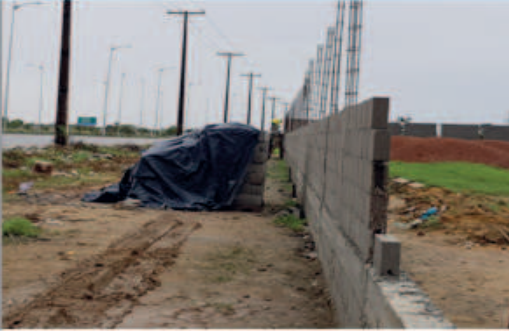
Blocos protegidos pela chuva
