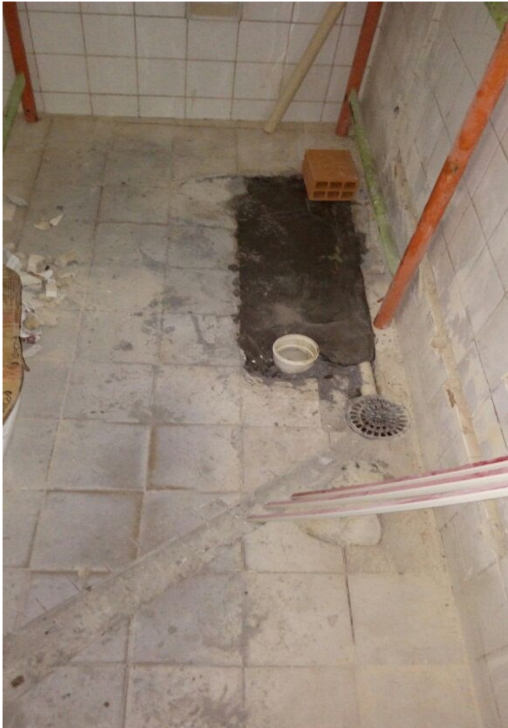
Preparo para receber esgoto
