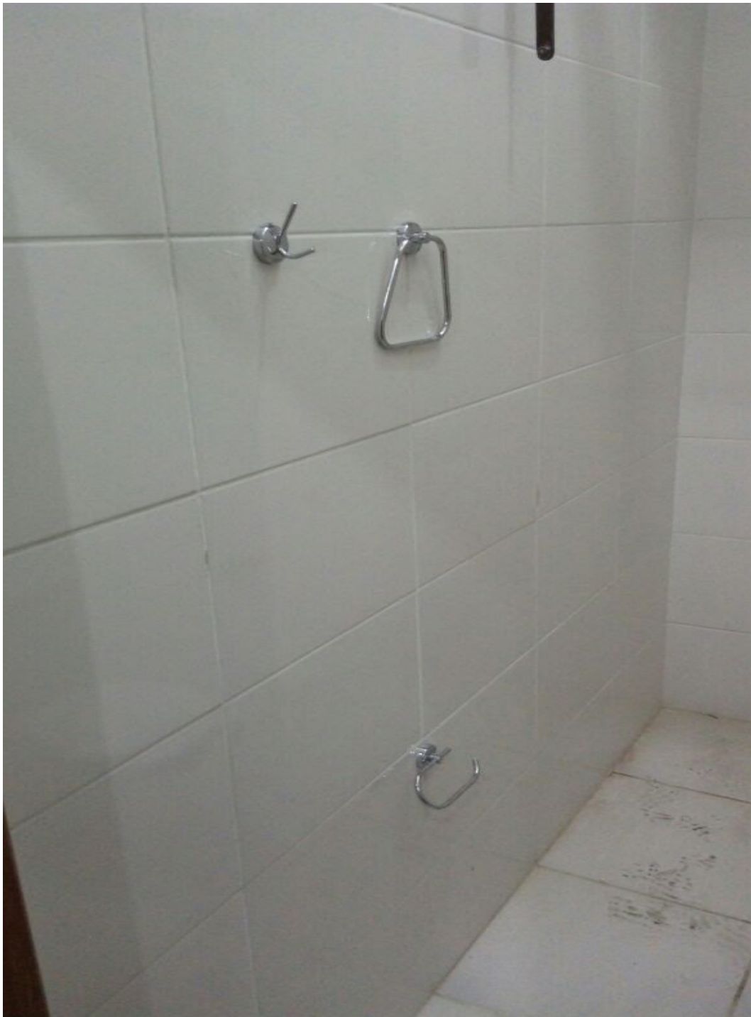
Revestimento de paredes e chão
