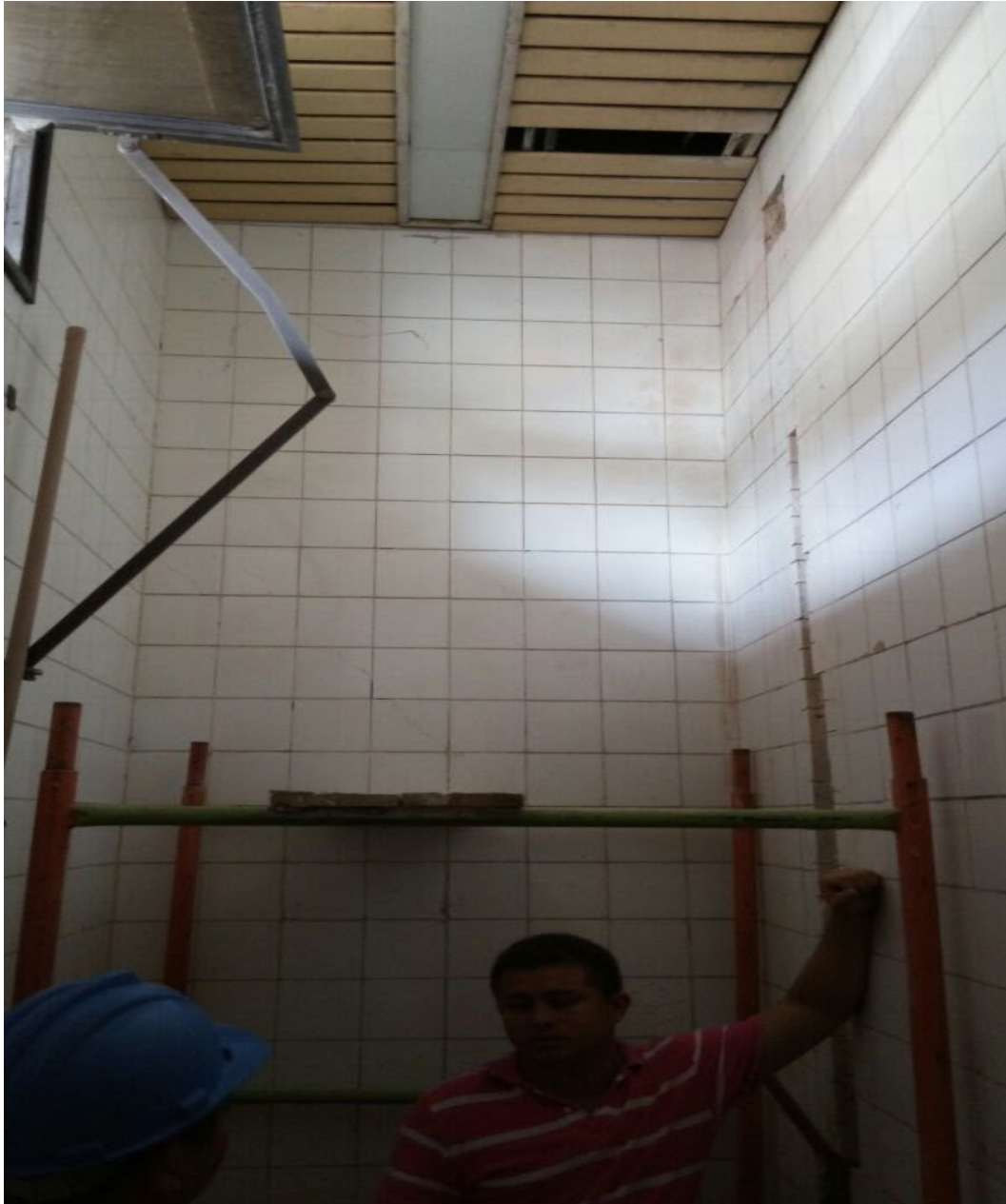
Banheiros antes da reforma
