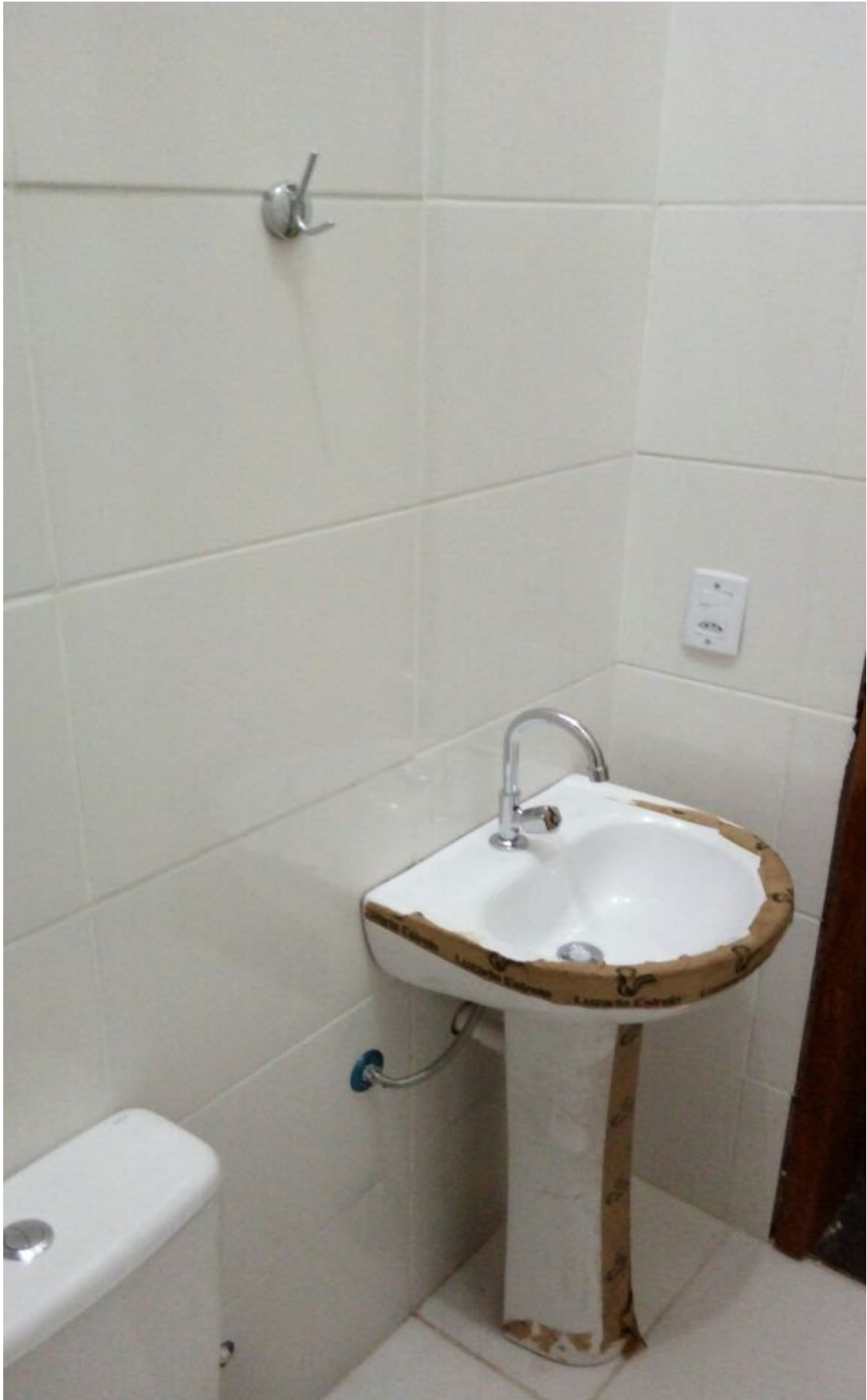
Paredes revestidas e louça nova
